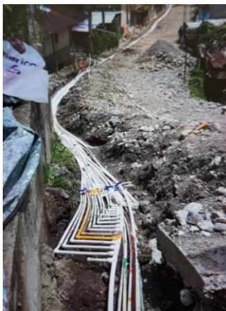
Introducción de tubería nueva de agua potable por proyectos de pavimento en 3 cuadras en la zona 4 salida a San Ramón
