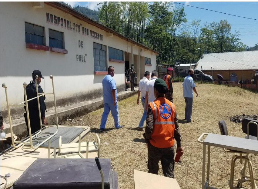
Figura 1: remodelación del hospital San Vicente de Paul
